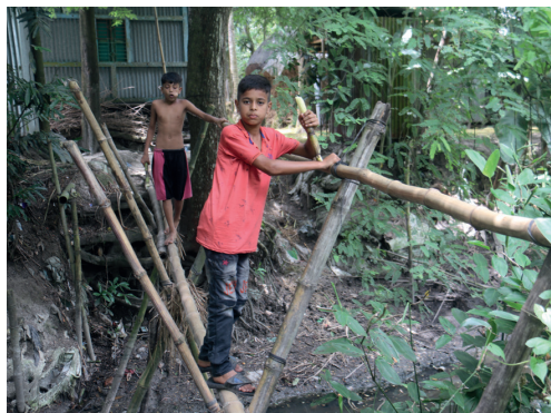
▲ 56. Voorbeeld van een eenvoudige balkbrug gemaakt van bamboe. De afbeelding maakt duidelijk dat de meest eenvoudige balkbruggen van minstens één handleuning moeten zijn voorzien geweest. De foto werd op 13 augustus 2022 gemaakt in Comilla, Bangladesh, door Martien van Asseldonk.
